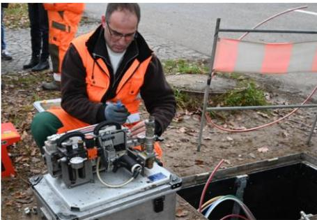
**Bild 2\_Prysmian Group Sirocco Extreme:** Prysmian Group bei der Installation des Glasfaserkabels Sirocco Extreme für Microkanäle im Auftrag der Stadtwerke Landau a.d. Isar. (Quelle: Prysmian Group)
